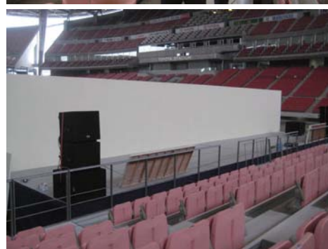
豊田スタジアムで野外ステージの設営現場
